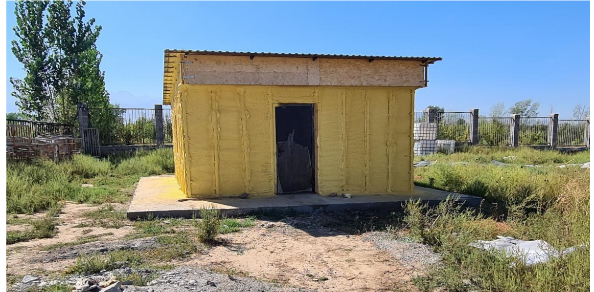
14. Водонапорная станция с артезианской скважиной 50куб/час водоснабжения , ёмкостями и насосной группой.
