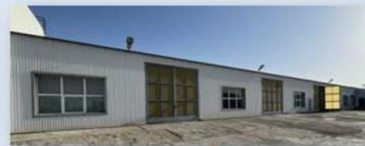
Литер Б – Помещение для ремонта грузовых автомобилей
