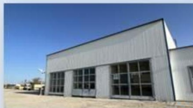
Литер В – Помещение для ремонта грузовых автомобилей
