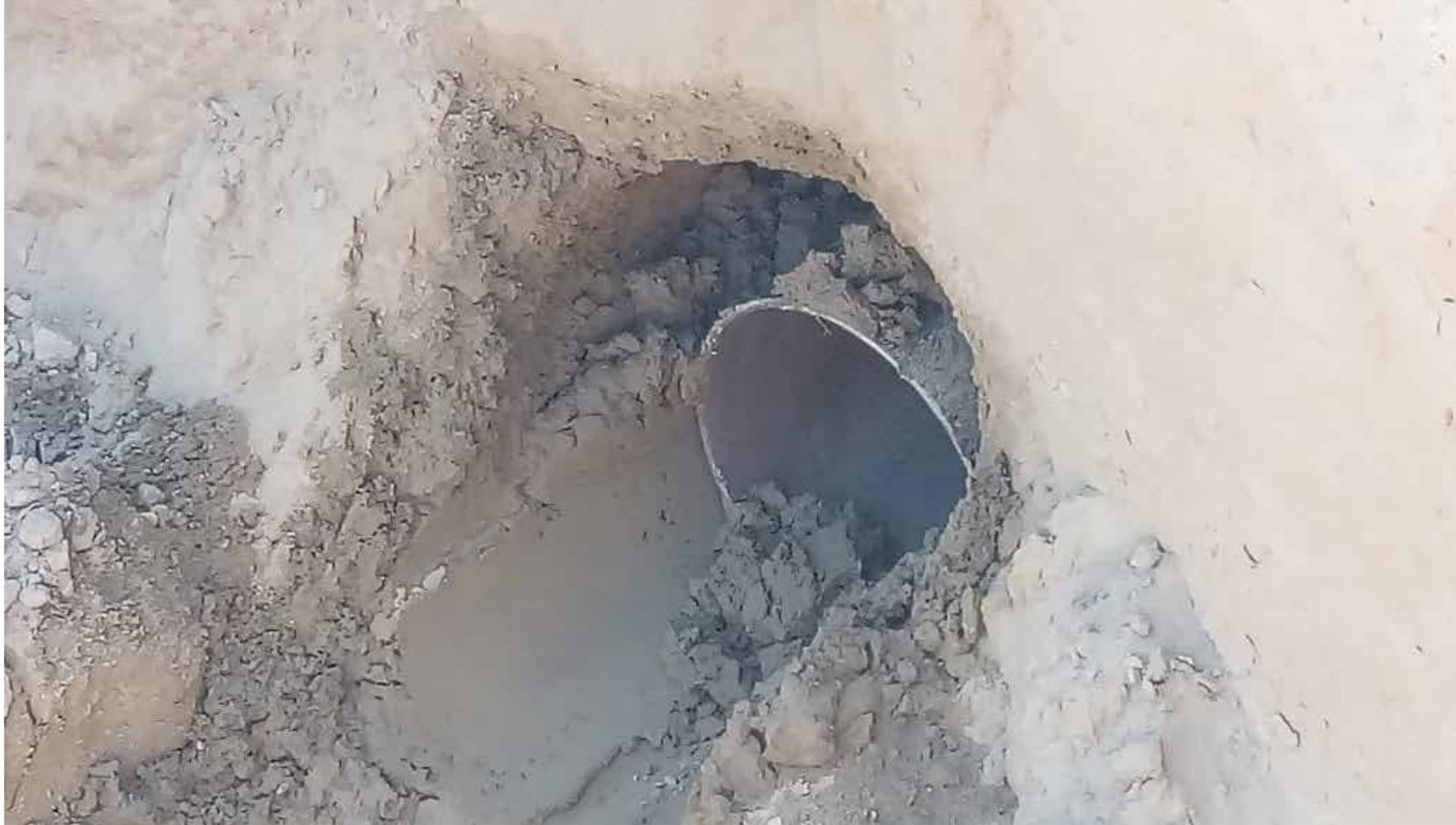
Баканас, Трасса Капчагай Баканас переход диаметром 530 мм длина 42 м
